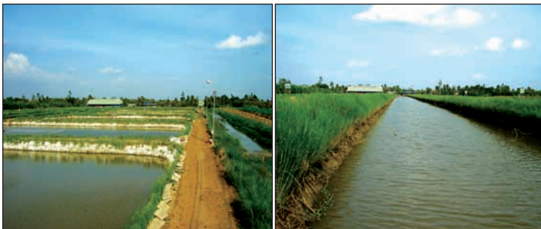
Foto 3: Controle de erosão e tratamento de esgoto em uma fazenda de peixes de água doce no Delta de Mekong.
