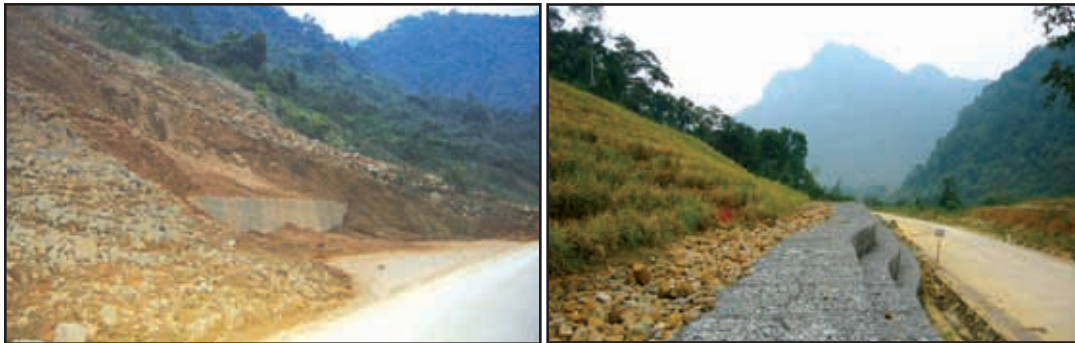
Foto 21: Da Deo Pass, Quang Binh: Esquerda: Cobertura vegetal é destruída, revelando falhas feias e contínuas de cortes nas encostas; direita: Linhas de Vetiver no topo da encosta espremem muito lentamente para baixo, reduzindo consideravelmente a massa que falhou.
