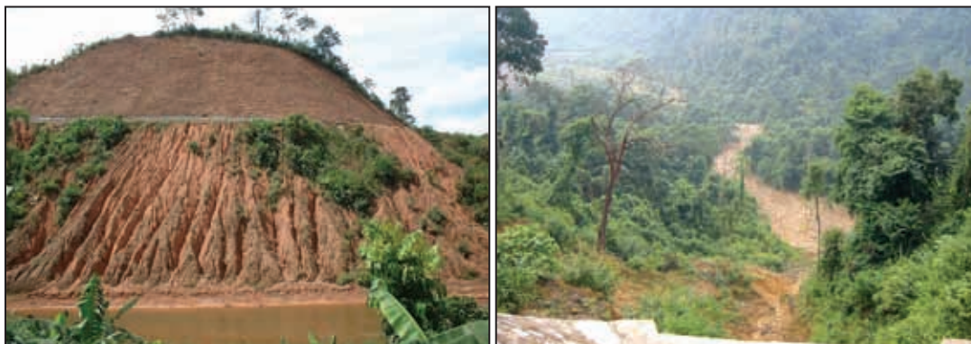
Foto 20: Esquerda; se for não devidamente protegida de rocha/ solo deste despejo de resíduos irá lavar rio abaixo para bem longe. Direita: O Impacto rio abaixo com uma aldeia no distrito de U Luoi, na província de Thua Tien Hue.
