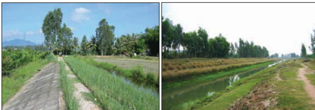
Foto 12: Proteção de anti-salinidade em uma seção de um dique com tradicional enrocamento de pedras de frente para o rio (à esquerda) e ao longo de uma seção de um canal de irrigação, a erosão da superfície desfigura a margem oposta (à direita).
