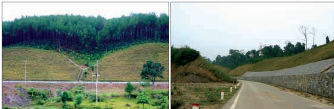
Foto 19: Esquerda: Plantas de Vetiver estabilizando cortes (rachaduras) ao longo das encostas da Rodovia (auto-estrada) da Cidade de Ho Chi Minh; direita: a planta sozinha e em combinação com medidas tradicionais.
