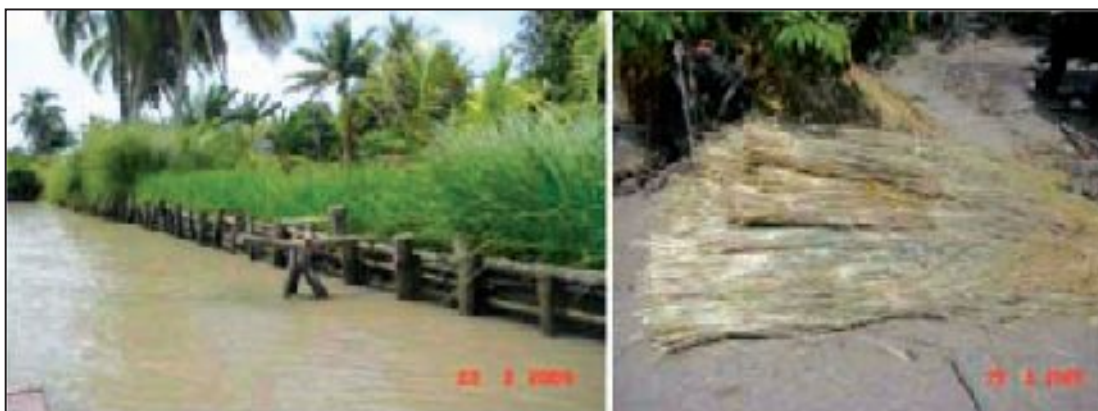
Foto 29: Esquerda: Vetiver reforça uma estrutura de madeira ao longo de um rio; direita: folhas cortadas de vetiver permite fazer cordão ou corda para amarrar as mudas de arroz.
