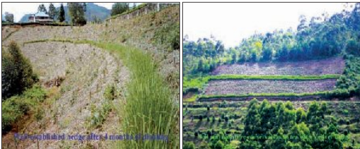
Foto 3: Barreiras de Vetiver plantadas em despenhadeiros de alta inclinação acerca de 1.700 m de altitude(a.s.l). Na área de Munnar do Ghats Ocidente da Índia, no estado de Kerala. Esta grande área de crescimento de chá sofre grave erosão. Todos os estados na área estão agora a adotar o Sistema Vetiver.
