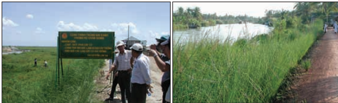
Foto 15: Em An Giang plantas de vetiver estabilizam um dique de rio (à esquerda), e a margem natural do rio (direita).
