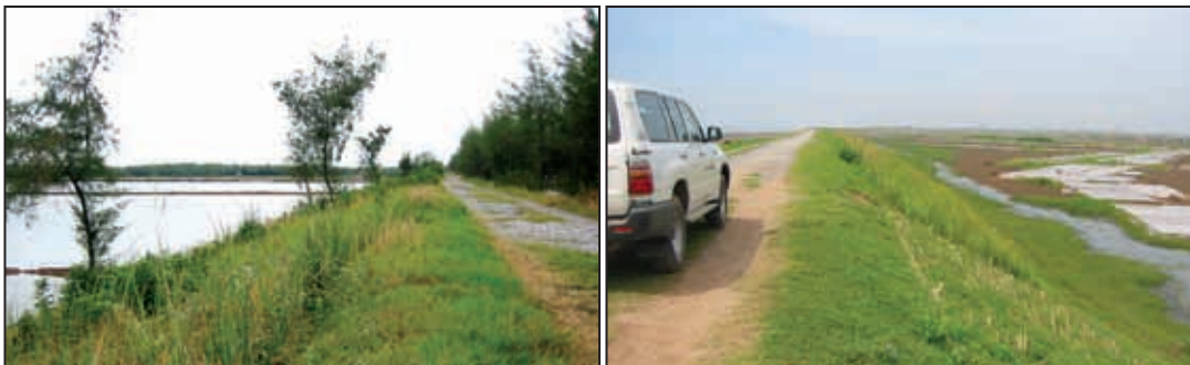
Foto 18: No Vietnã do Norte; esquerda: Gramas de Vetiver plantadas no lado exterior de um dique construído recentemente no mar da província de Nam Dinh; direita: no lado interno do dique, plantada pelo departamento local de Diques.
