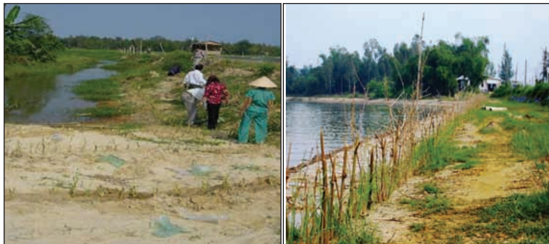
Foto 8: Esquerda: Março de 2002: SV executado à beira de uma lagoa de camarão, onde um canal drena águas das cheias de Vinh Dien River; direita: Novembro de 2002: o plantio em massa combinado com enrocamento de rochas para proteger as margens (bancos) ao longo do rio Vinh Dien.
