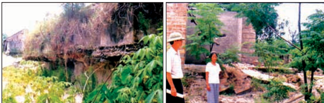
Foto 2: Fluxos de areia em Le Thuy (Quang Binh) em 1999: a fundação de uma estação de bombeamento (esquerda) e a fundação da casa de três quarto desta mulher foi danificada pelo movimento da areia (à direita).
