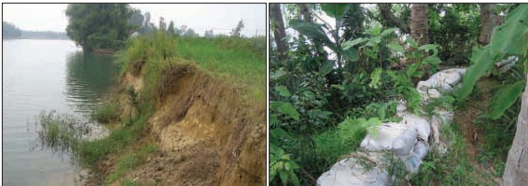
Foto 13: Esquerda: Margens severamente erodidas do Rio Tra Khuc, na Comunidade de Binh Thoi; direita: Primitivo saco de areia de proteção.
