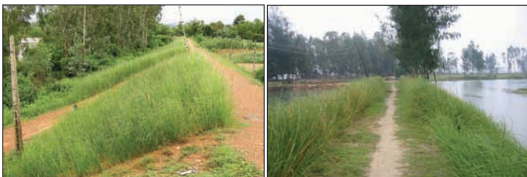
Foto 11: Esquerda: Plantas de Vetiver plantadas no dique do rio ao longo do Rio Tra Bong; direita: revestimento nas laterais do dique de uma entrada (embocadura) de anti-salinidade ao longo do mesmo rio.
