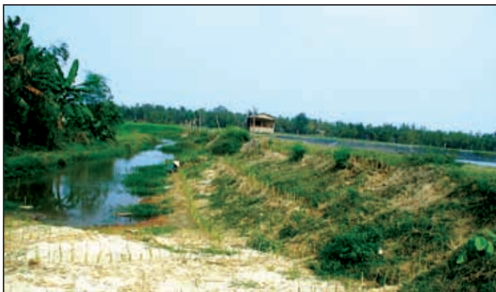
Foto 21: Barreiras de Vetiver protegendo uma lagoa de camarão próxima de um barranco natural que drena a água para dentro de um rio (na província de Da Nang), este modelo foi criado como parte do primeiro projeto de vetiver financiados pela Embaixada Real dos Países Baixos (Holanda) no Vietnã.
